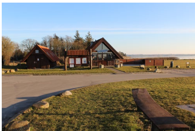
Foto 1 < Eksisterende toiletbygning og cafe/kiosk, som kan erstattes af ny servicebygning A2, set fra nord mod syd. Fotovinkler ses i bilag 7.
